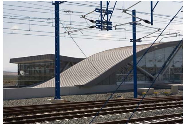
Foto 5. Estación de Sta Ana. Antequera (Málaga)
